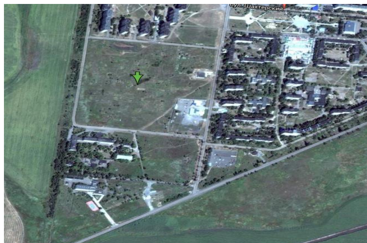
Рисунок 1.1 – Передбачуване місце будівництва
